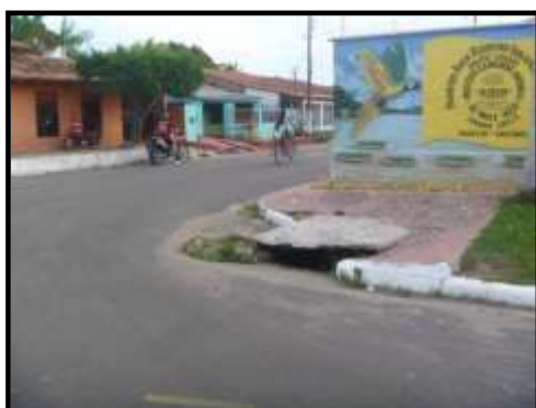
Ilustração 5.4.2.1: Boca-de-lobo de Guia com depressão em via publica em Parintins/AM.
