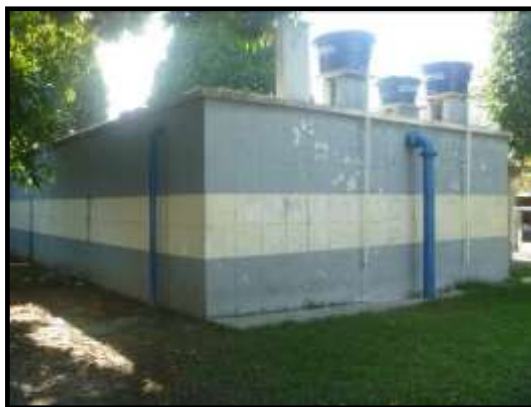
Ilustração 5.1.5.2 – RA em concreto armado com capacidade para 90.00 m 3 na estação Paraíba.
