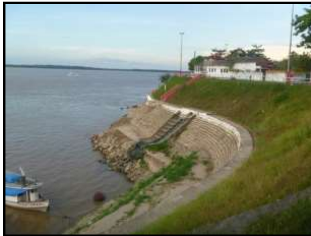
Ilustração 5.4.3.2 – Lançamento de águas pluviais a margem do rio Amazonas em Parintins.
