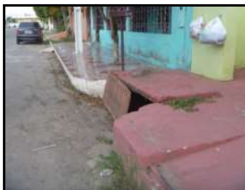
Ilustração 5.4.2.2: Boca-de-lobo tipo Guia com depressão no Bairro da COAB-AM em Parintins/AM.
