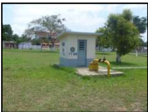
Ilustração 5.1.1.1 – Poço Tubular na Estação de Abastecimento da SHAM em Parintins/AM.
