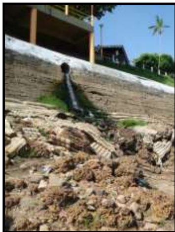
Ilustração 5.4.3.1. – Lançamento de águas pluviais a margem do rio Amazonas em Parintins/AM.
